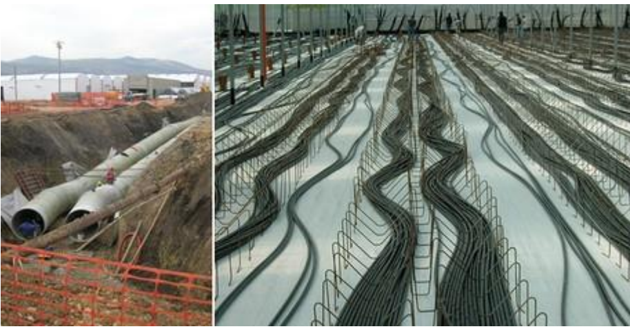
Buizen die van de centrale naar de kas gaan.
