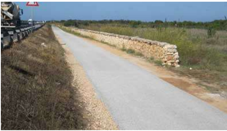
Nella foto il manto in i.idro DRAIN della pista ciclabile di Torre del Guaceto a Brindisi
