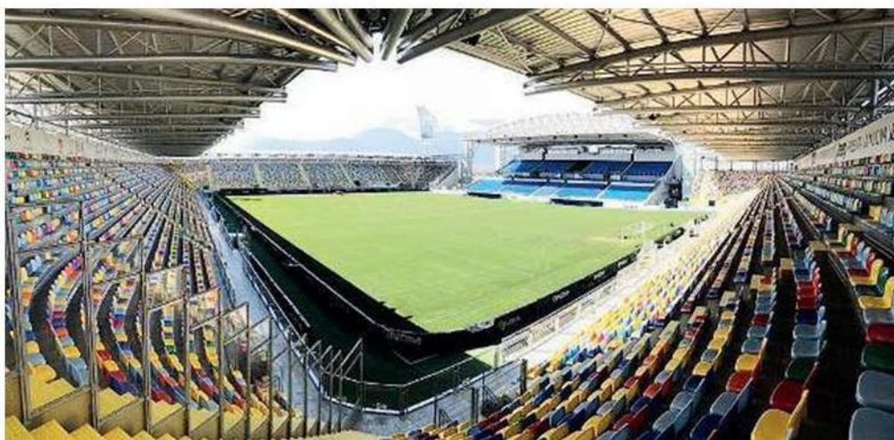
Frosinone. Uno dei modelli per Brescia (ma senza copertura), realizzato con tribune metalliche da Manca
