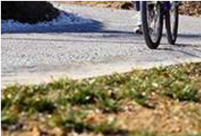
una pista ciclabile realizzata in I.idro Drain
